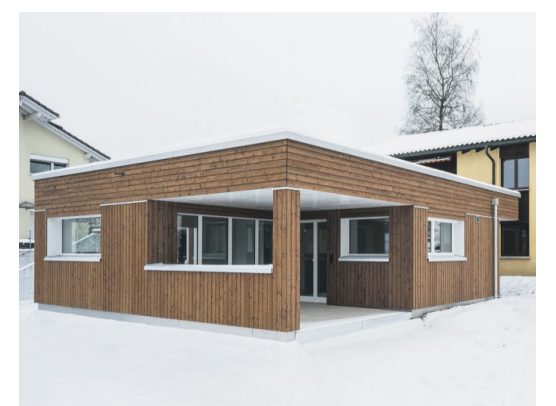
Anbau einer 1 1/2-Zimmerwohnung in Adligenswil LU.
